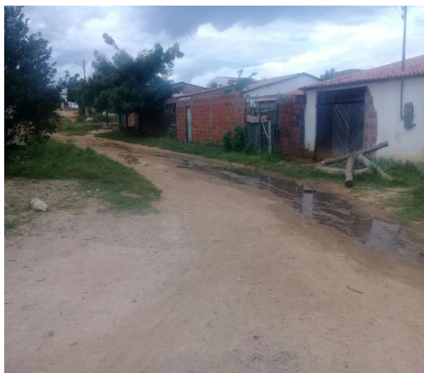
Figura 6 - Rua sem pavimentação e sem saneamento básico– Bairro Flores. Fonte: Arquivo pessoal.
